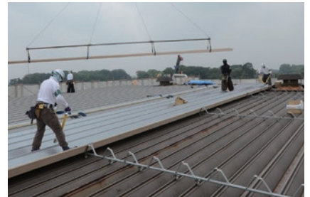
③新規屋根材の取付
