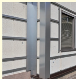
コーナー補強板Lの取付け
