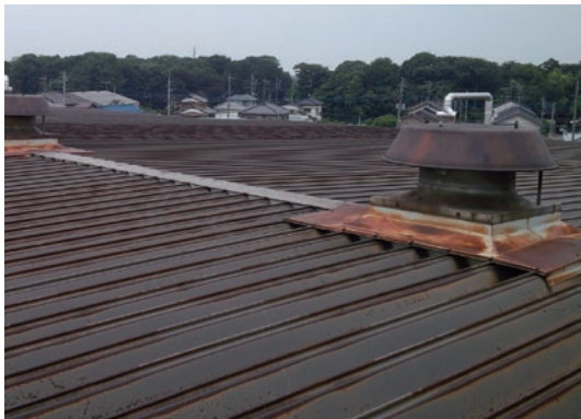
▲改修前 丸はぜ折板333
