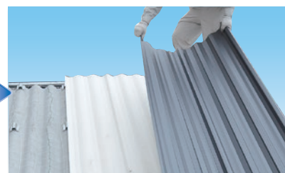
屋根材を裏面材に被せ金具に固定して完成
