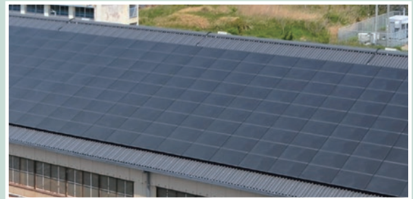
⑤施工完了後の屋根面
