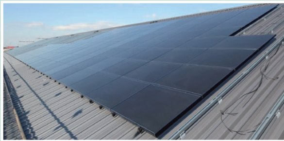
④ソーラーパネルを設置します
