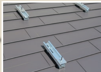
②本体金具を後付金具にかぶせて、付属のナット (M8) で留付けます。
