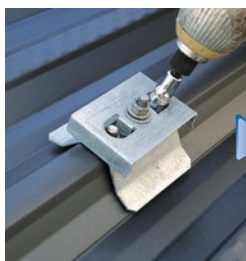
PV金具を取付け
