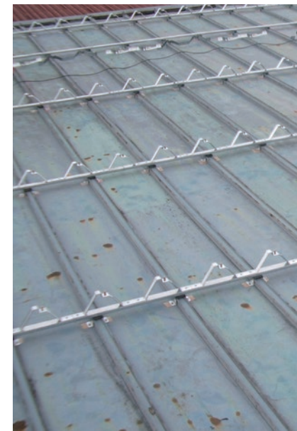
③タイトフレームの取付け
