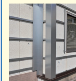
コーナー補強板 L の取付け
