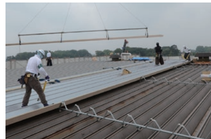
③新規屋根材の取付
