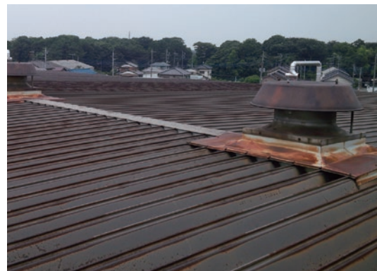
▲改修前 丸はぜ折板333
