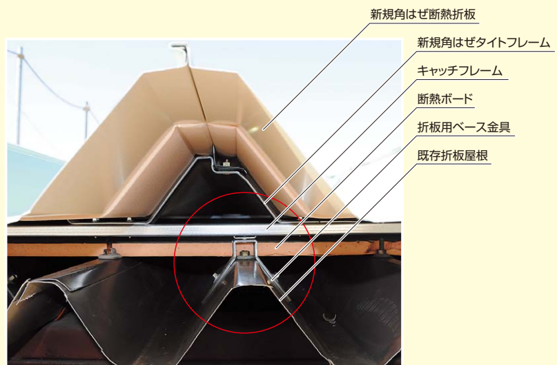
改修した断熱二重葺きの断面
