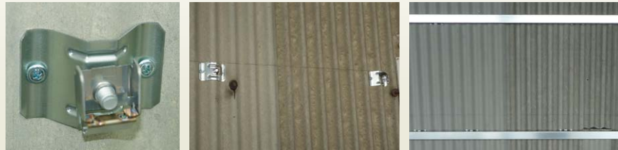
ベース金具 ベース金具を胴縁へビス留め キャッチフレームの取付け
