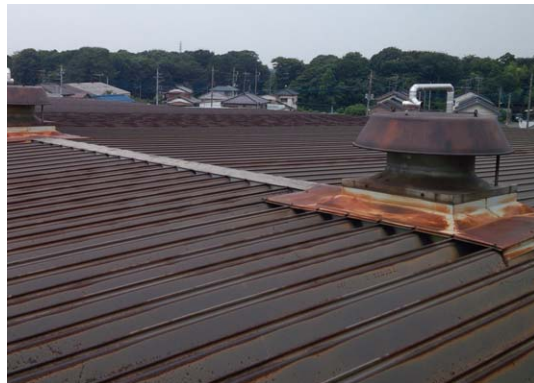
▲改修前 丸はぜ折板333
