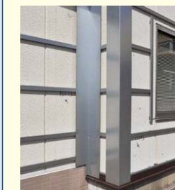
コーナー補強板Lの取付け
