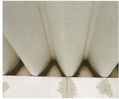
評価試験終了後(ガラス繊維マット耐火層)
