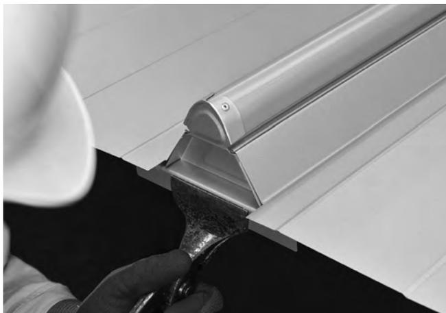
10-2 本体の軒先部（唐草先端から20mm出したドブ底）も同じ要領で掴み込みます。この時、専用の立上げ器（軒先・水上兼用）を使うと作業が楽できれいに仕上がります。
