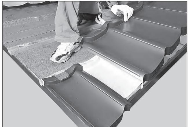
▲軒先袖瓦を吊子で固定し軒先瓦を取付ける
