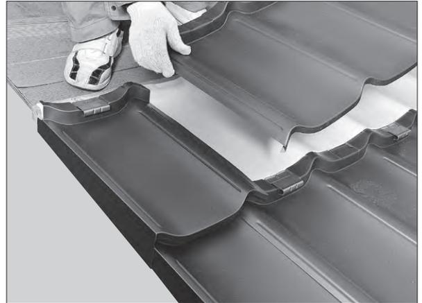
▲袖瓦(左)を吊子で固定し本体瓦を取付ける
