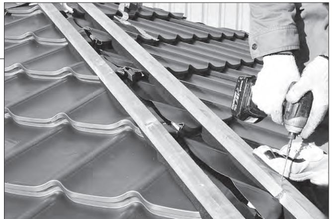
▲下り棟の施工はケミカル面戸の敷込みから。ケミカル面戸は栈木で押え込んで本体瓦に圧着
