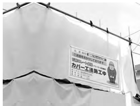
▲足場を利用して設置した粉塵飛散防止シート
