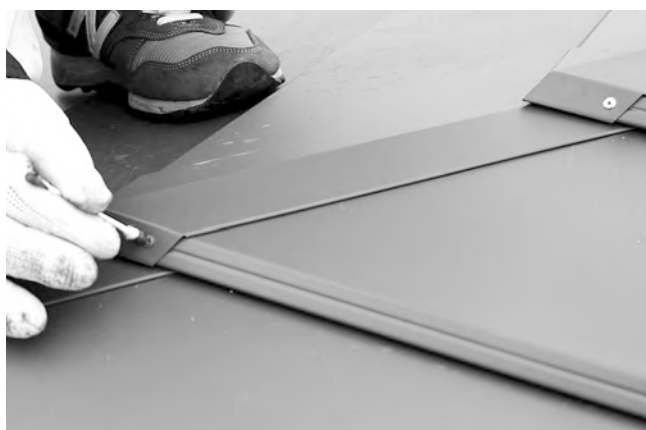
9-5 ビス・リベットの頭は、本体と同色の補修塗料でタッチアップします。
