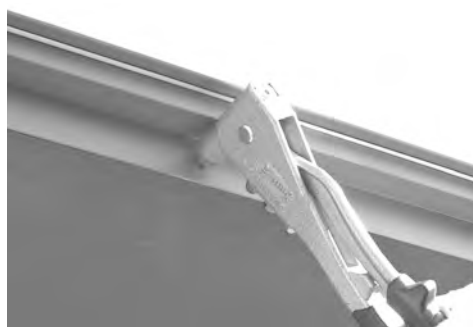
▲既存屋根の唐草にリフォーム専用の唐草をIC役物用鋼板ビスまたはリベットで留め付ける
