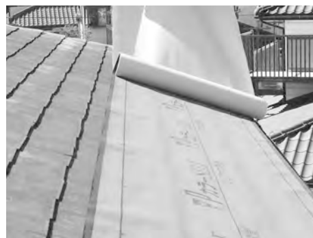
▲屋根面を清掃し、粘着ゴムアス系下葺材の敷込み作業
