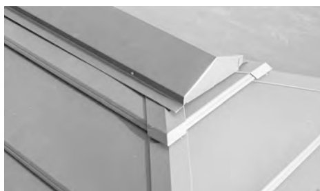
⑤ 棟包みの取付け。
