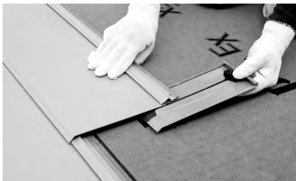
① ジョイント捨て板を取付けます。
