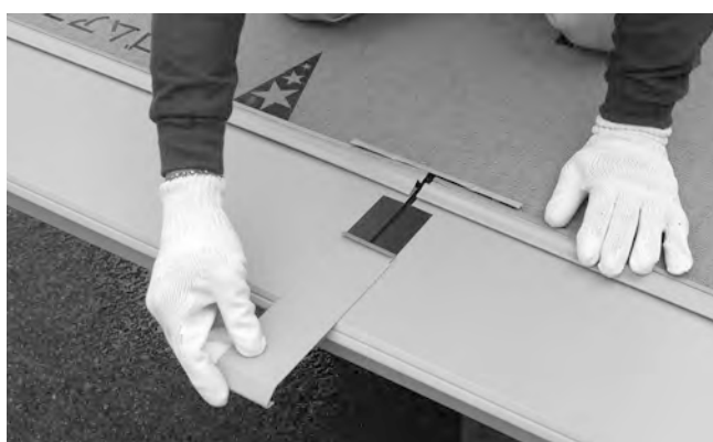
③ 化粧キャップをツメに沿って挿入します。
