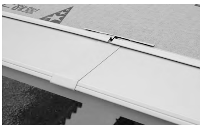
④ 化粧キャップを取付けたジョイント部の納め。
