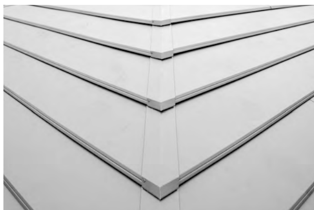
9-6 完成した降り棟の納め
