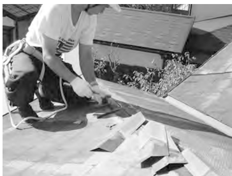
▲既存屋根の板金役物撤去作業
