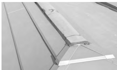
④ 棟下地に下葺材を被せる。
