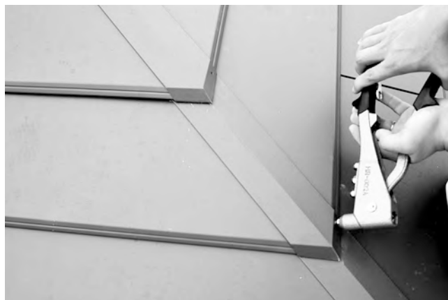
9-4 化粧キャップは、ねじれや脱落を防ぐために役物用鋼板ビスまたはリベットで本体に留め付けます。
