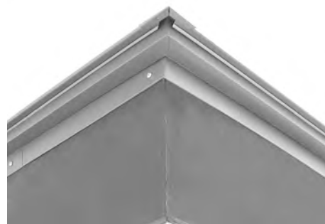
▲取付が完了した軒先唐草の納め
