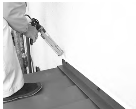
▲差込式雨押え部のコーキング処理
