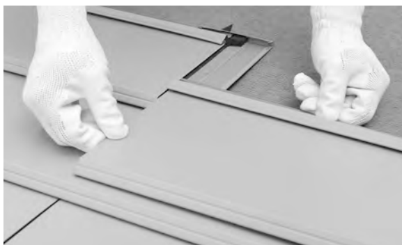
② 本体の端部を捨て板のツメに差込みます。
