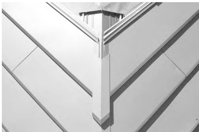
9-5 ビス・リベットの頭は、本体と同色の補修塗料でタッチアップします。
