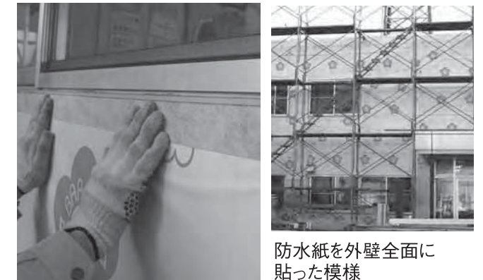
4 窓廻り等の開口部に防水テープ貼り付け
