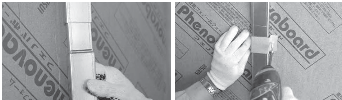
フレームに中間ストッパーの取付け
