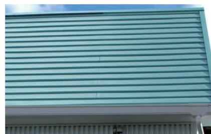
キャップ工法 施工例
