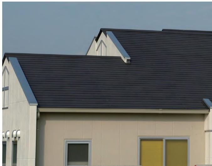
キャップレス工法 施工例
