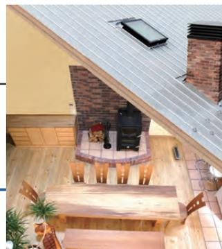
IC制振・断熱屋根材は裏面にサウンドブルーフ(軽量制振シート)を工場で貼わせて一体化した商品です。雨滴の振動エネルギーを制振樹脂で吸収し、静かで快適な室内環境づくりに役立つ新しい屋根材です。
