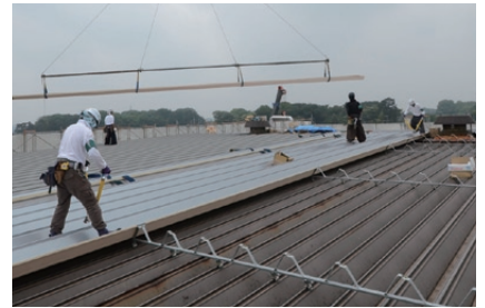
③新規屋根材の取付
