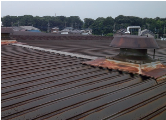
▲改修前 丸はぜ折板333
